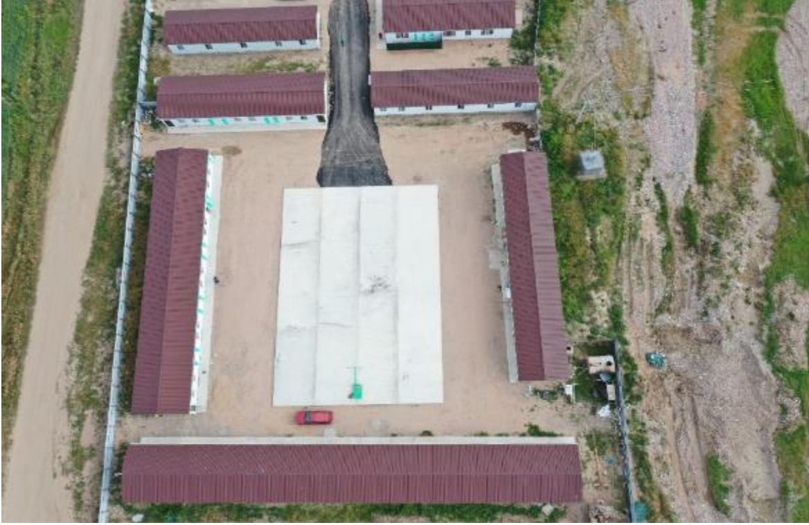
Figure 10: Camp site (km 148+630)
